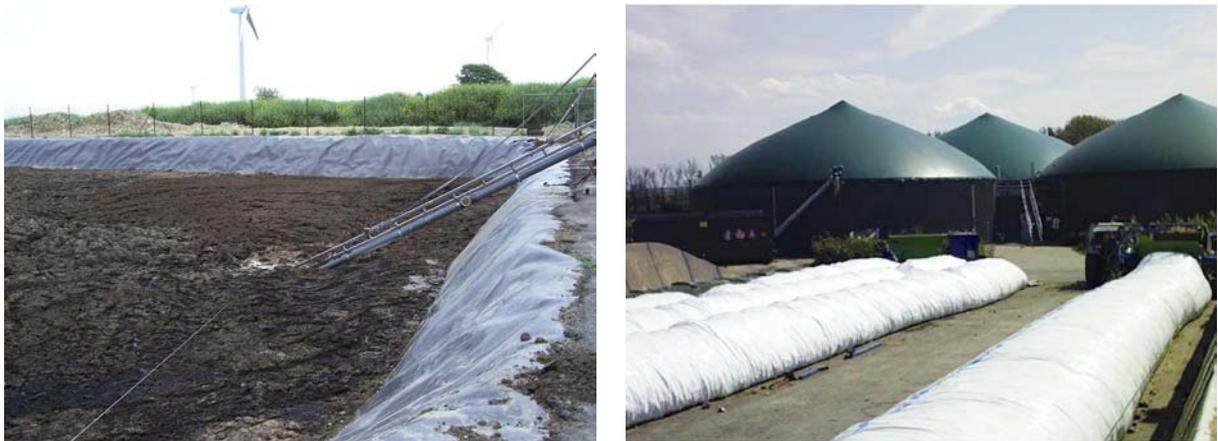
**Abb. 10:** Erdbecken mit pumfähigem Rübensubstrat (links) und Zuckerrüben in Schlauchsilage (rechts)
