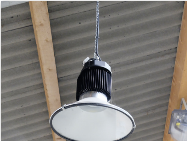
Abbildung 12: Kühlrippen einer LED-Leuchte
