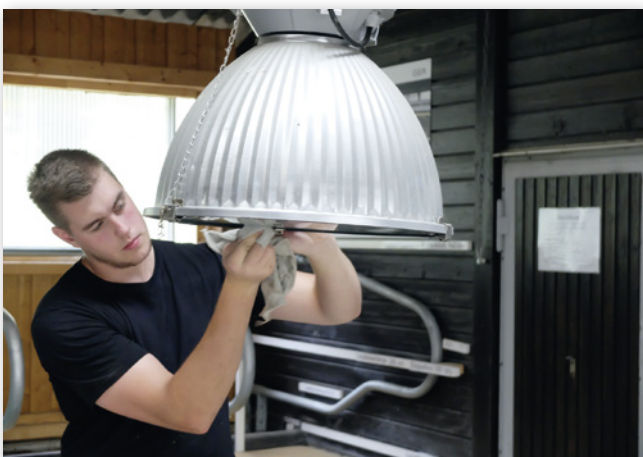
Abbildung 14: Bildung von Staub und Spinnennetzen im Stallbereich und Ablassvorrichtung zwecks Reinigung der Leuchten
