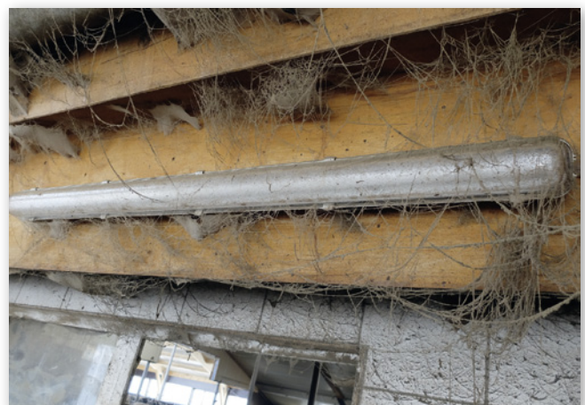
Abbildung 14: Bildung von Staub und Spinnennetzen im Stallbereich und Ablassvorrichtung zwecks Reinigung der Leuchten
