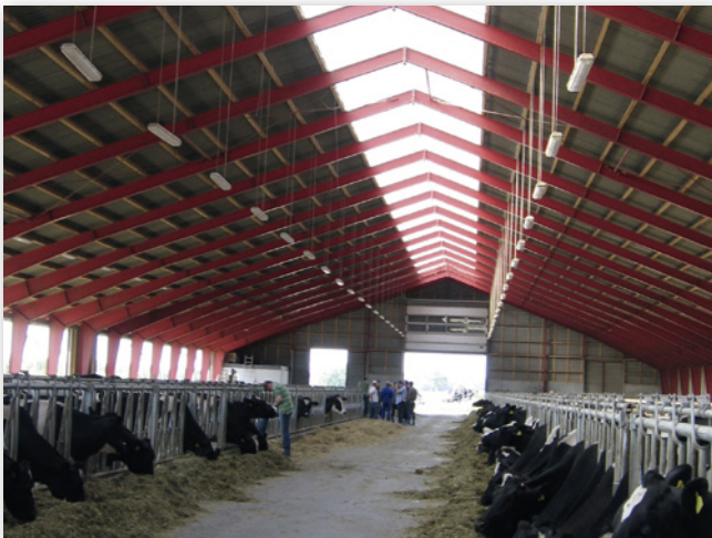
Abbildung 9: Praktisches Beispiel für das Abhängen der Leuchtstoffröhren
